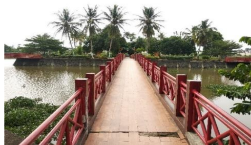
Gambar 2. Akses jembatan ke Pulau Cempaka
