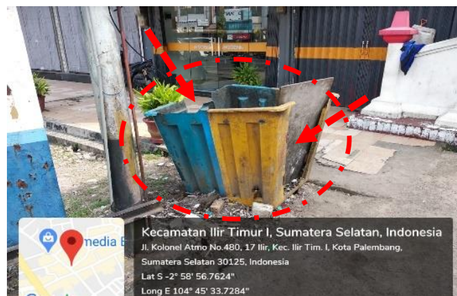
Gambar 5. Kerusakan di Bak TPS Fiber
