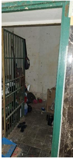
Gambar 13 Kondisi Ruang Brangkas Saat ini Sumber : Dokumentasi Pribadi
