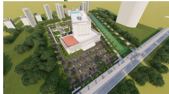
Gambar 14. Tampak Bangunan dari Atas
